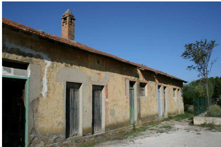
Ancien baraquement laissé en l'état du quartier Poincard, Sorgues
